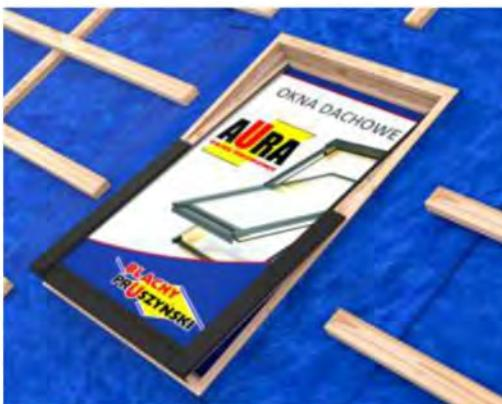
Pentru finalizarea asamblarii ferestrei de mansarda, trebuie sa fixam membrana intr-un mod standard si sa pastram etanseitatea conexiunilor.
