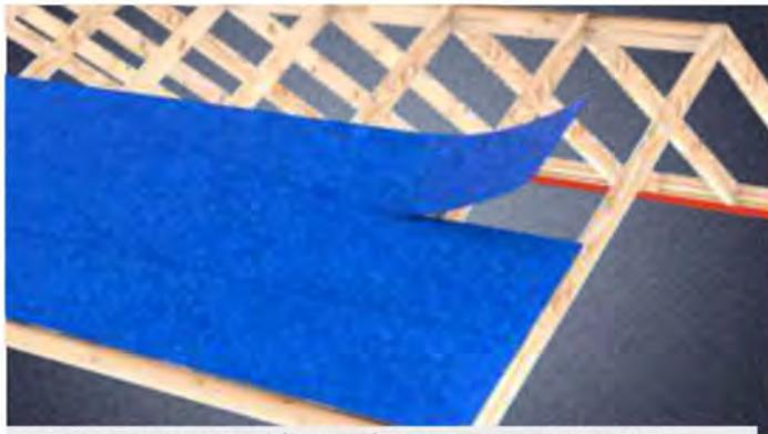
Toate acoperisurile invelite cu panouri REGLE au nevoie initial de o membrana sau carton bituminos pentru acoperis.
