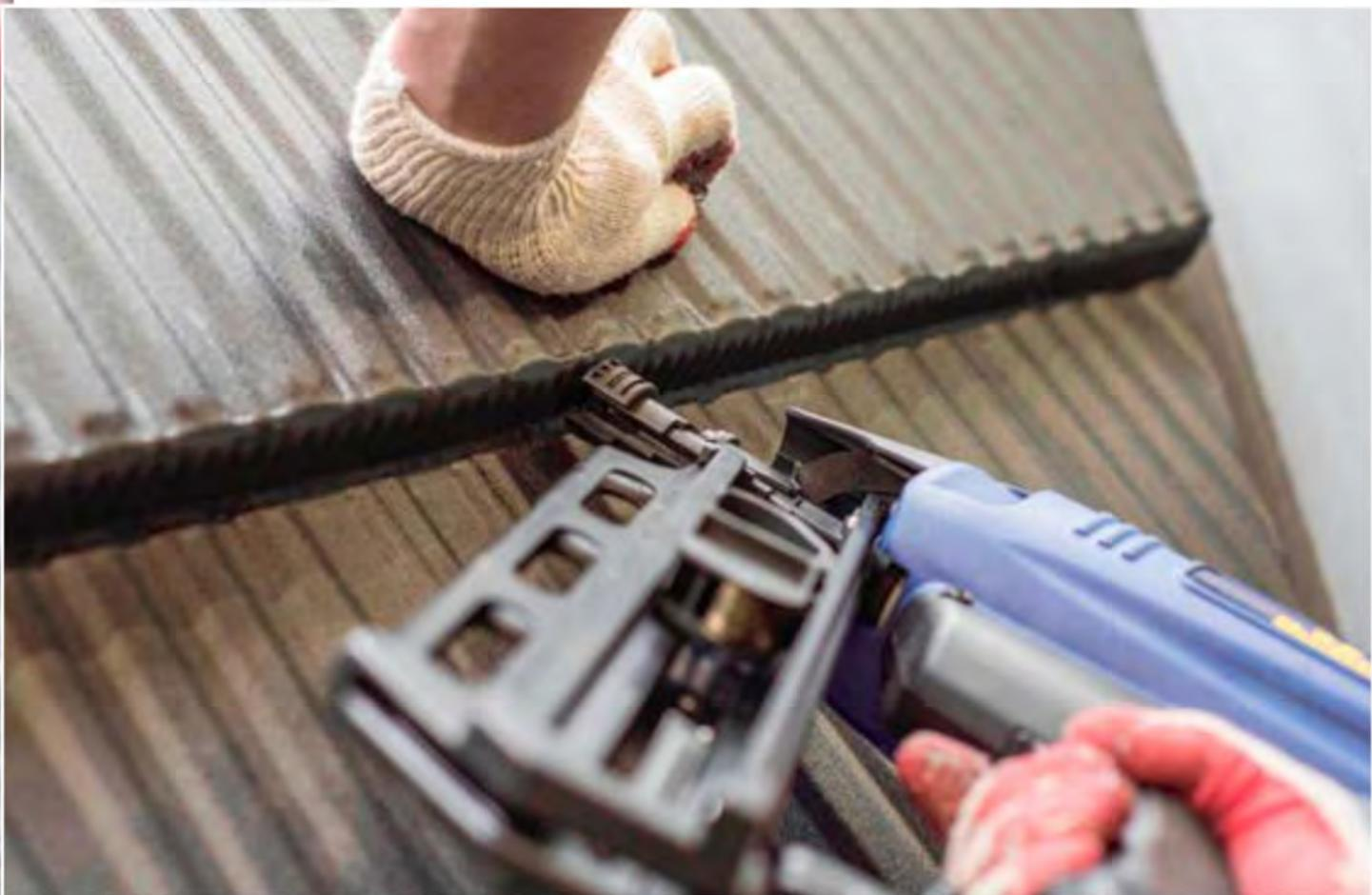
Panourile ar trebui asamblate cu ajutorul unei masini de batut cuie. Partea frontală a panoului ar trebui batuta in cuie pe sipci. Acest sistem asigura etanseitate, o asamblare rapida si estetica, avand in vedere izolatia invizibila. Ar trebui sa folositi 10 cuie pe 1m<sup>2</sup>.
